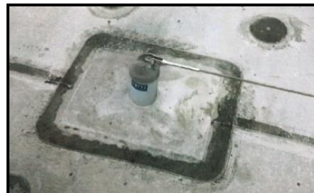
Potelet d'extrémité Evolution monté sur toitures (neuf et installé)
