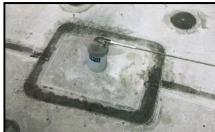
Paletto di testa Evolution montato su tetto (nuovo e installato)
